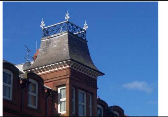
FIGURE 20. A MANSARD TURRET DEFINES THE ROOFLINE
